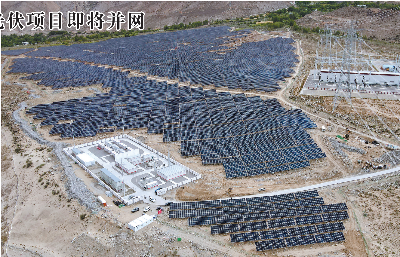
图为朗县冲康35MW光伏+储能项目。
