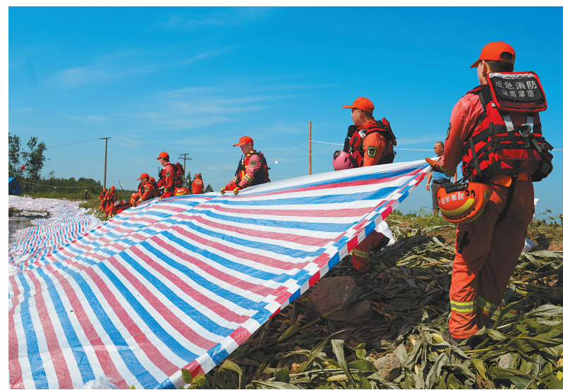
自7月5日湖南省岳阳市华容县团洲垸洞庭湖一线堤防决堤后,加固“第二道防线”的工作持续紧张进行。“第二道防线”是离决口约两公里处的钱团间堤,这是一道横亘在团洲垸和钱南垸之间、长约14.3公里的间堤。抢险队伍对间堤堤身堤脚清基加固,铺设彩条布、巡堤查险,全力守住“第二道防线”。图为7月7日,抢险人员在钱团间堤修复和加固彩条布。
