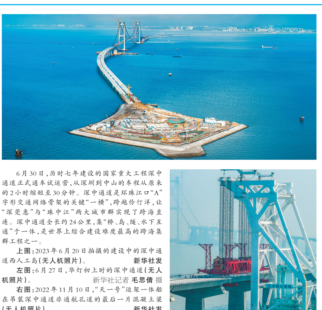
6月30日,历时七年建设的国家重大工程深中通道正式通车试运营,从深圳到中山的车程从原来的2小时缩短至30分钟。深中通道是珠江口“Y”字形交通网络骨架的关键“一横”,跨越伶仃洋,让“深莞惠”与“珠三角”两大城市群实现了跨海直连。深中通道全长约24公里,集“桥、岛、隧、水下互通”于一体,是世界上综合建设难度最高的跨海集群工程之一。
