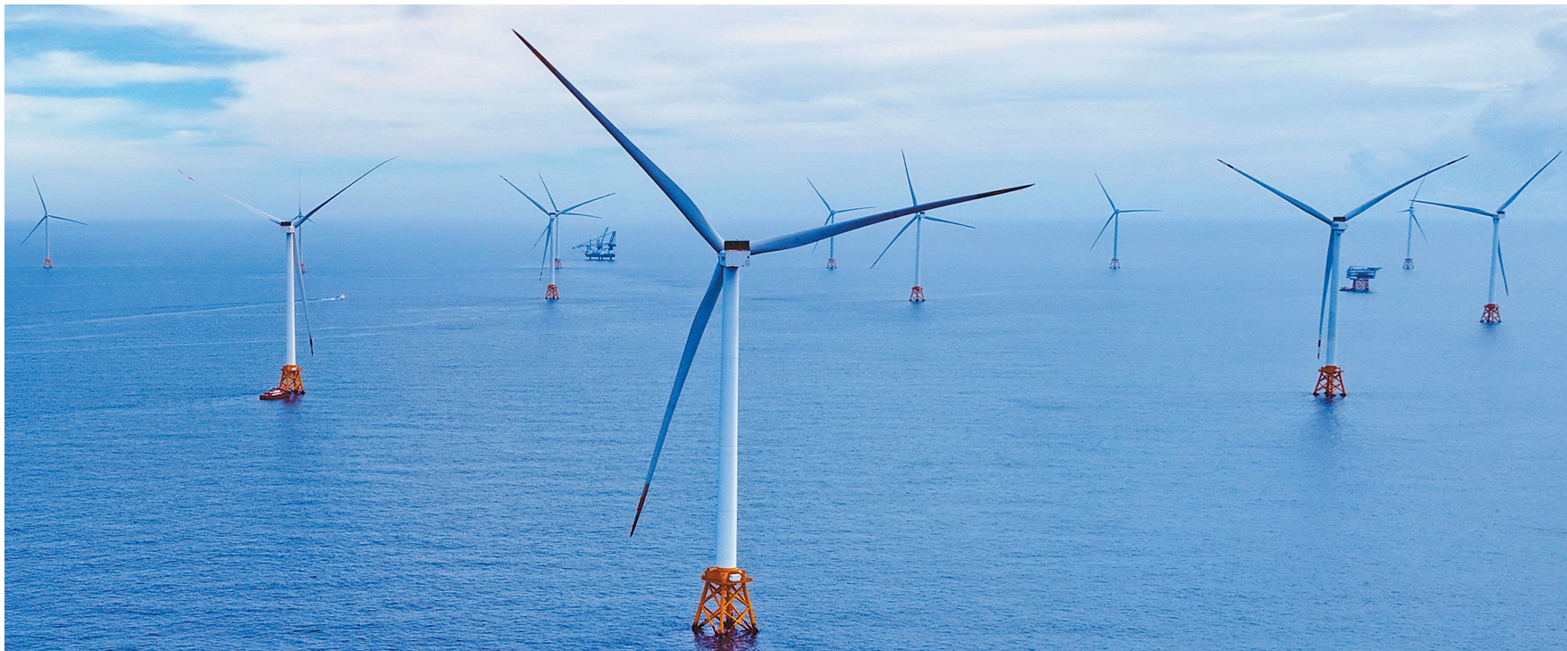
6月27日，全国首个超大单机容量的海上风电机组项目——三峡集团漳浦二期海上风电项目实现全容量并网发电。
