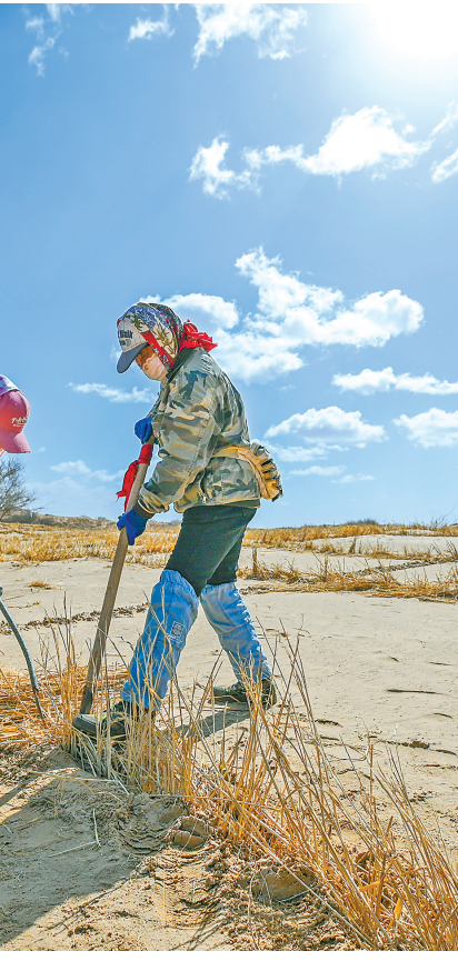
图为在内蒙古通辽市科尔沁左翼后旗阿古拉镇,治沙工人在科尔沁沙地打草方格(2024年3月28日摄)。
