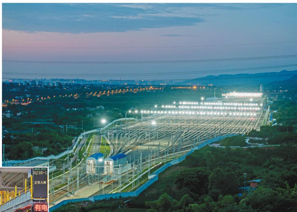
天府动车所位于四川天府新区太平街道,由中铁十九局、中国铁建电气化局集团承建,规划总面积约2090亩,是西南地区最大的动车所,有检修线12条,可同时检修24组标准动车组,最大可担当每天90组标准动车组的检修任务。
