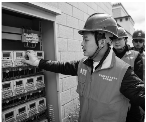
国家电网工作人员对社区集中电箱进行供电排查。
