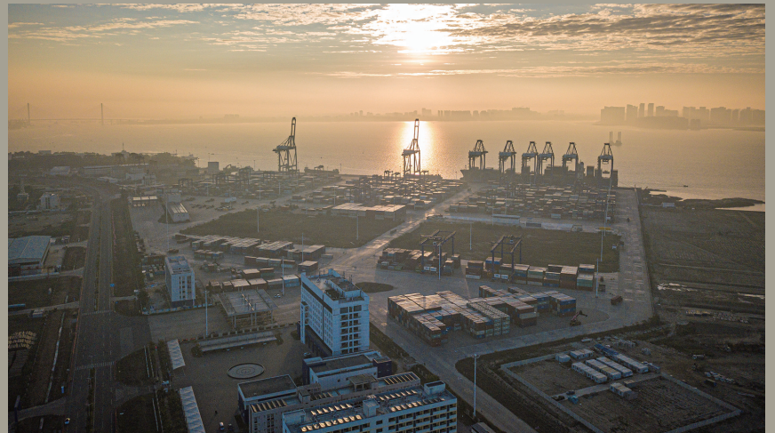
海南自贸港重点园区——洋浦经济开发区的洋浦国际集装箱码头。新华社
