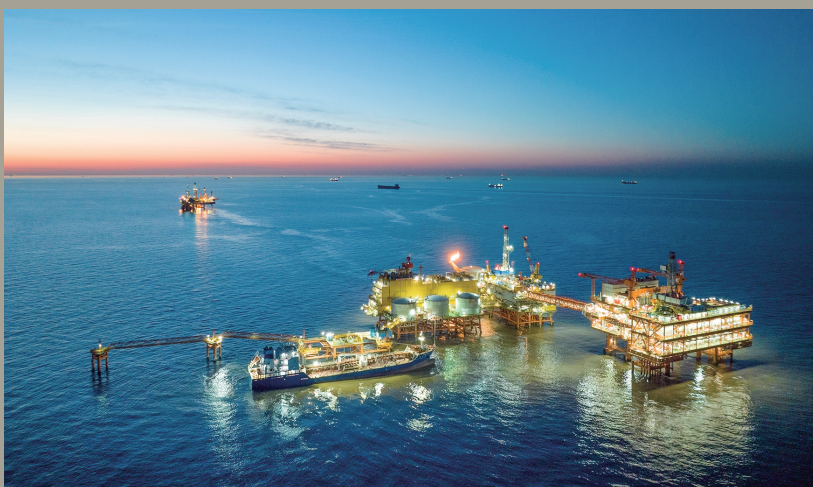
位于渤海湾西南部的埕北油田油气处理与岸电设备共建平台——CEPC(中心平台)正式投产。新华社
