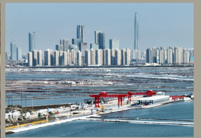
津潍高铁津沽海河隧道超大直径盾构机“津城一号”始发现场。新华社
