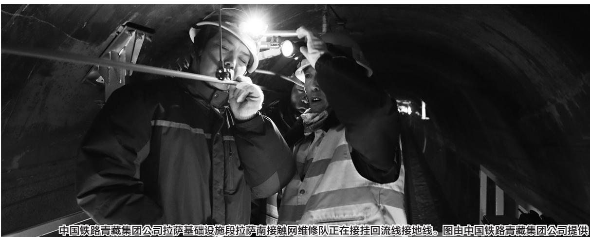
中国铁路青藏集团公司拉萨基础设施段拉萨南接触网维修队正在接挂回流线接地线。图由中国铁路青藏集团公司提供
