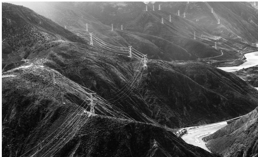
川藏联网工程输电线路。图片来源国网西藏电力有限公司
