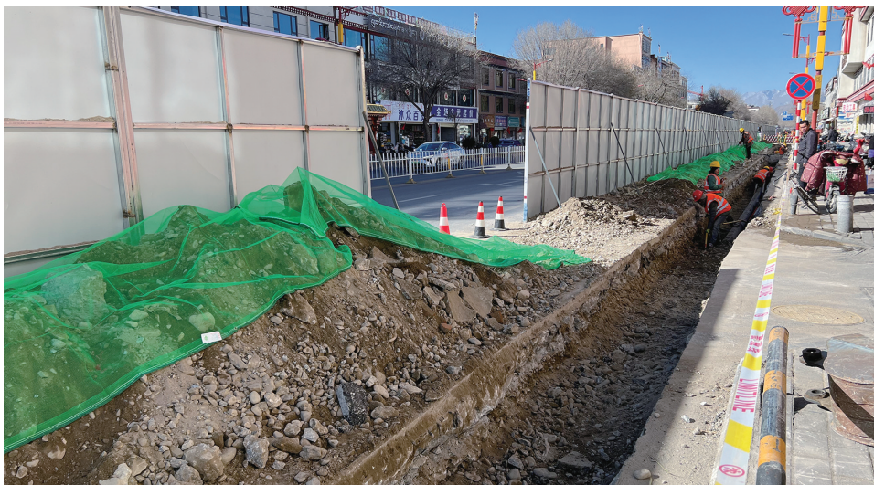
纳金路路面的挖掘工程。
