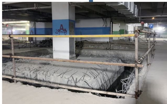
地下停车场施工现场。
