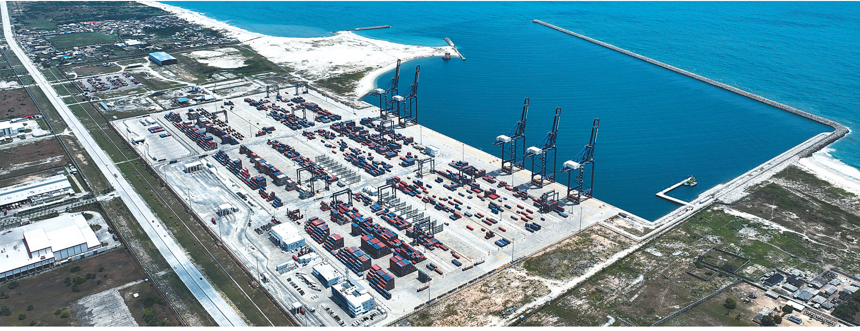
由中国港湾工程有限责任公司承建的尼日利亚莱基深水港位于中尼合作建设的拉各斯莱基自贸区内,是尼日利亚首个现代化深水港和最大港口,年设计处理能力120万个标准集装箱。莱基深水港项目于2020年6月开工,2022年10月竣工,2023年1月正式开港运营。 图为3月1日在尼日利亚拉各斯拍摄的莱基深水港(无人机照片)。 新华社记者 韩旭 摄
