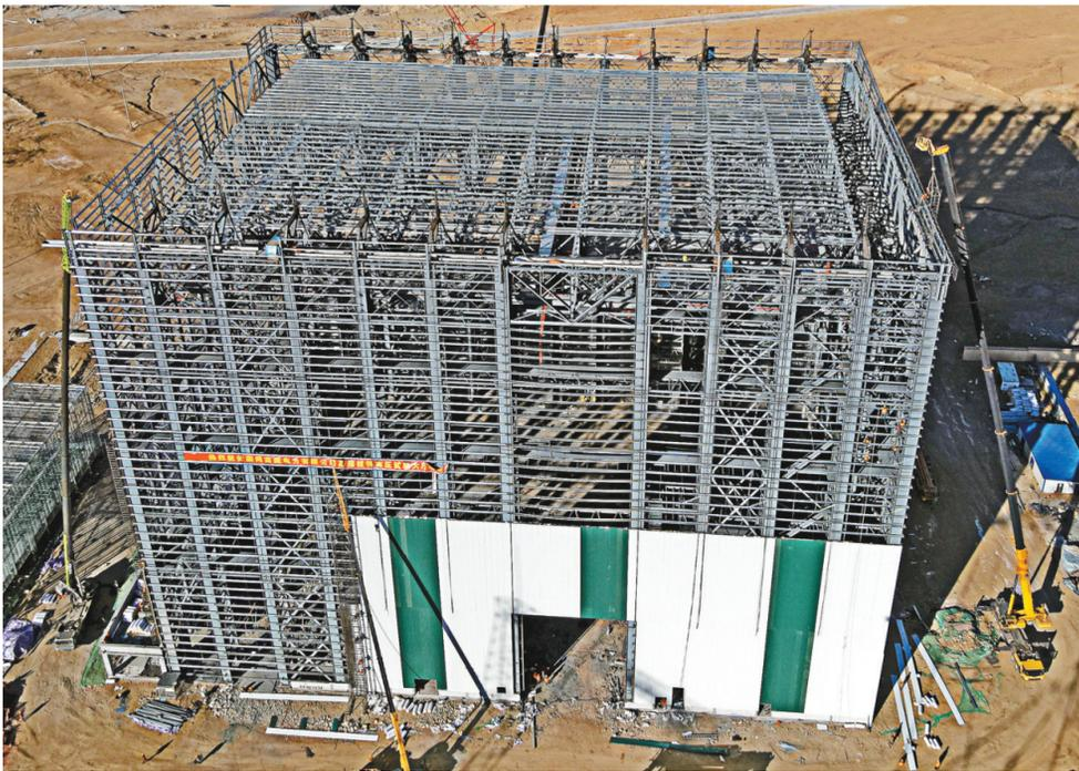
日前,位于当雄县羊八井的世界海拔最高、净空尺寸最大、综合试验能力最强的西藏海拔特高压试验大厅屋面桁架整体提升完毕。
