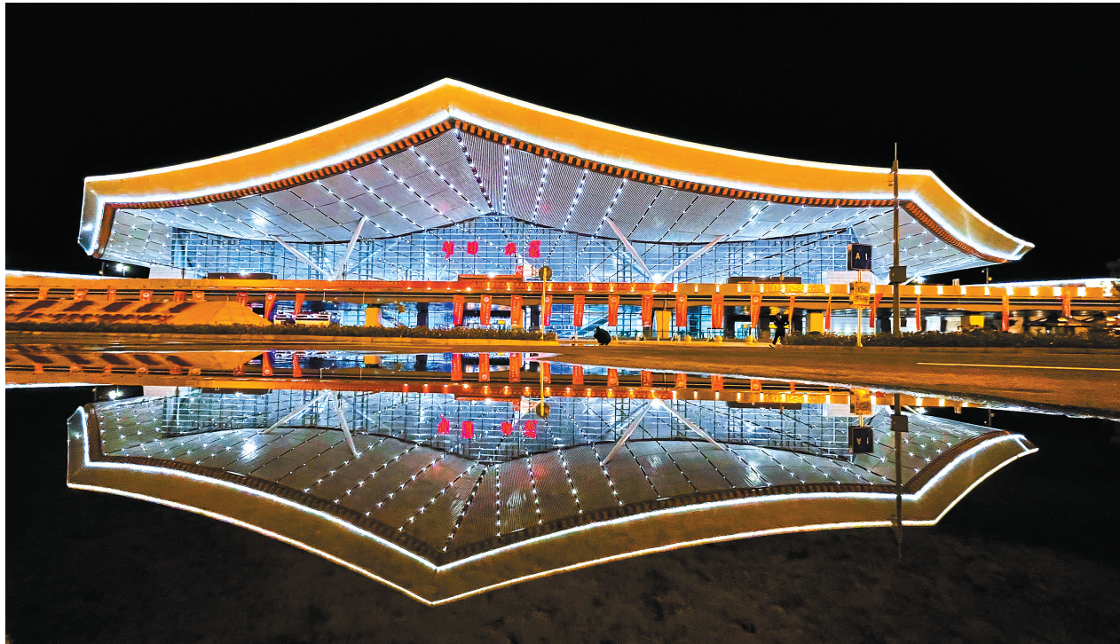
图为拉萨贡嘎机场T2航站楼。
