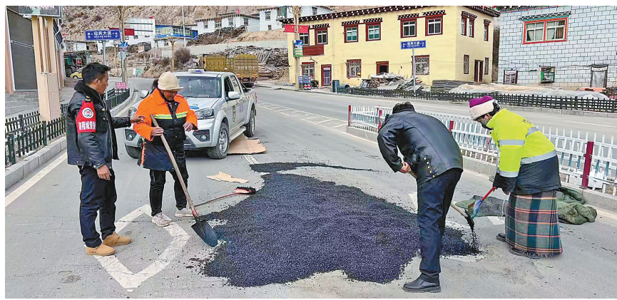
图为洛隆县组织公路养护队开展路面修复工作。
