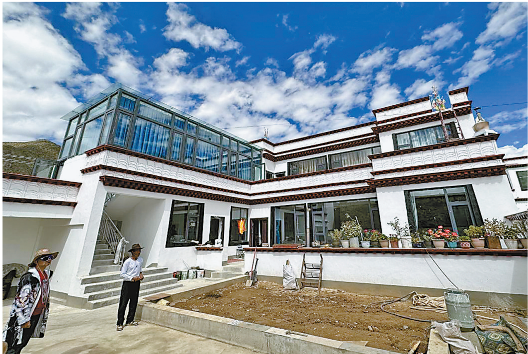
达孜区“美丽乡村·幸福家园”建设项目群众住房改造后外观。
