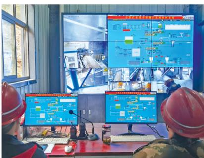
图为中凯矿业帮中铜铜矿充填控制系统。
