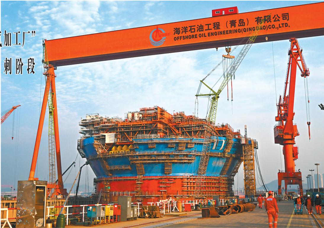
近日,由我国自主设计建造的亚洲首艘圆筒型“海上油气加工厂”——“海洋石油122”浮式生产储卸油装置(FPSO),在青岛进入最后的总装集成冲刺阶段。据介绍,“海洋石油122”船体直径约90米,设计排水量10万吨,可连续海上作业15年不回坞。
