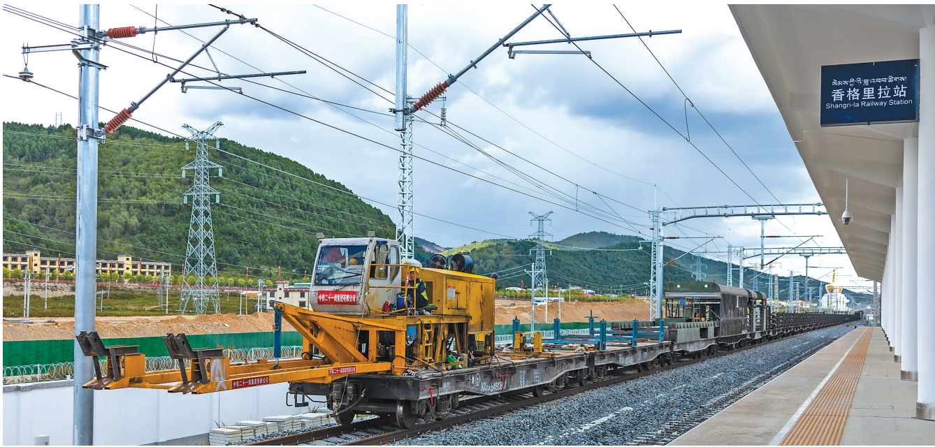
9月19日，在云南省迪庆藏族自治州香格里拉站施工现场，随着最后一对500米长钢轨精准落在道床上，滇藏铁路丽江至香格里拉段全线铺轨完成，为年内开通运营奠定坚实基础。丽香段开通运营后，迪庆藏族自治州将结束不通铁路的历史。
